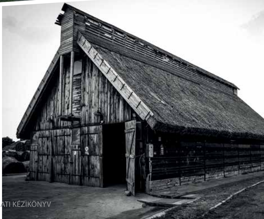
Családi házas szövetbe ékelődő vízműtelephely.
